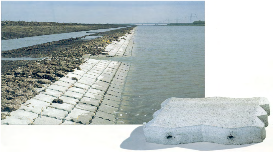
3.11 pav. Šlaitų tvirtinimas betono blokelių lanksčiomis konstrukcijomis
