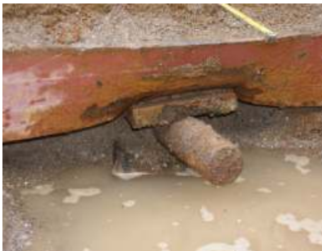
Paskirstomosios sijos pažaidos -pasisukę dvitėjų viršutinės lentynos, nulenkti jos sparneliai
