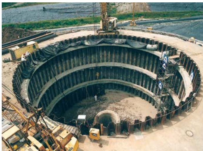
Landfill site, Asslar
