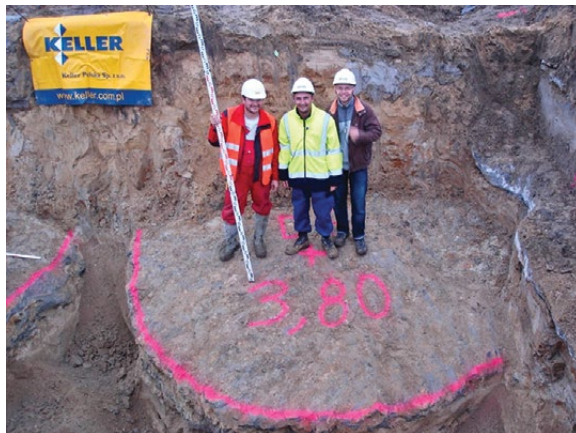
9.16 pav. 2008 m. pasiektas didelio slėgio injekcijos Lenkijos rekordas 3,80 m skersmens gruntbetonio kolona ( www.keller.com.pl/aktualnosci.html )
