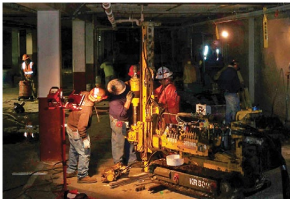
10.10 pav. Srautinio injektavimo polių įrengimas pastato rūsyje ( http://www.structuremag.org/article.aspx?articleid=1029 )
