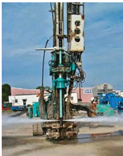
9.13 pav. Srautinės injekcijos technologijos eiliškumas: 1 – gręžimas; 2 – pasiekus projektinį lygį, injektavimo pradžia; 3 – injektuojama monitorių keliant ir sukant
