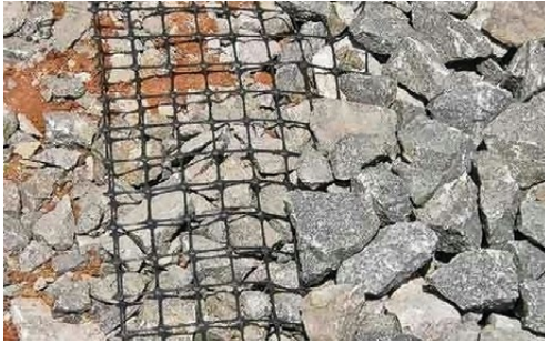
9.20 pav. Geotinklas skaldos sluoksnyje ( http://www.agrinets.com/geo-synthetics.html )
