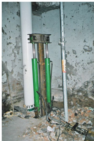
10.14 pav. Polių įspaudimo dviem hidrauliniiais domkratais įranga
