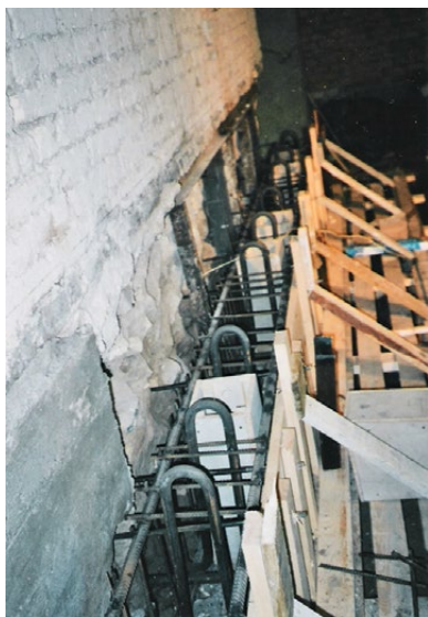
10.13 pav. Rostverko spaustiniams poliams įrengimas
