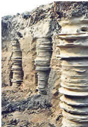
9.15 pav. Srautinės injekcijos būdu suformuotos gruntbetonio kolonos paviršius būna labai nelygus ( http://www.dallagassa.com/templates/index.php?id=64&menu=35 )
